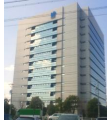
日本ガイシ(株)本社ビル
