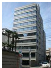
伊藤忠丸の内ビル (名古屋)
