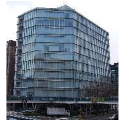
大樹生命名古屋ビル
