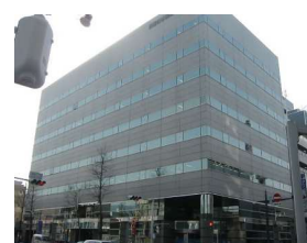
県信松本深志ビル
